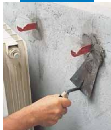
Colocación de garras para radiadores con Lampocem
