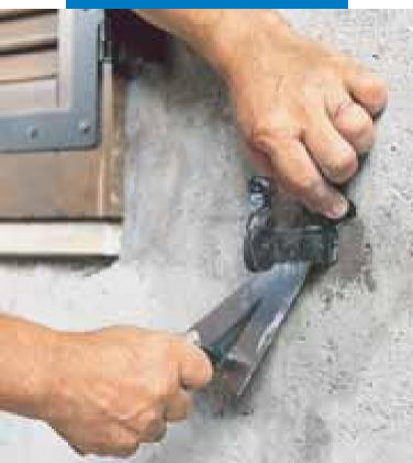
Colocación de grapas para ventanas con Lampocem
