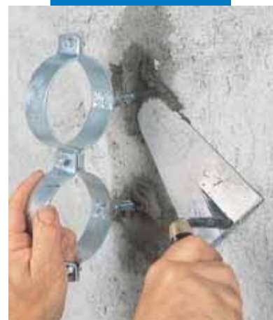
Fijación de abrazaderas para cañerías con Lampocem
