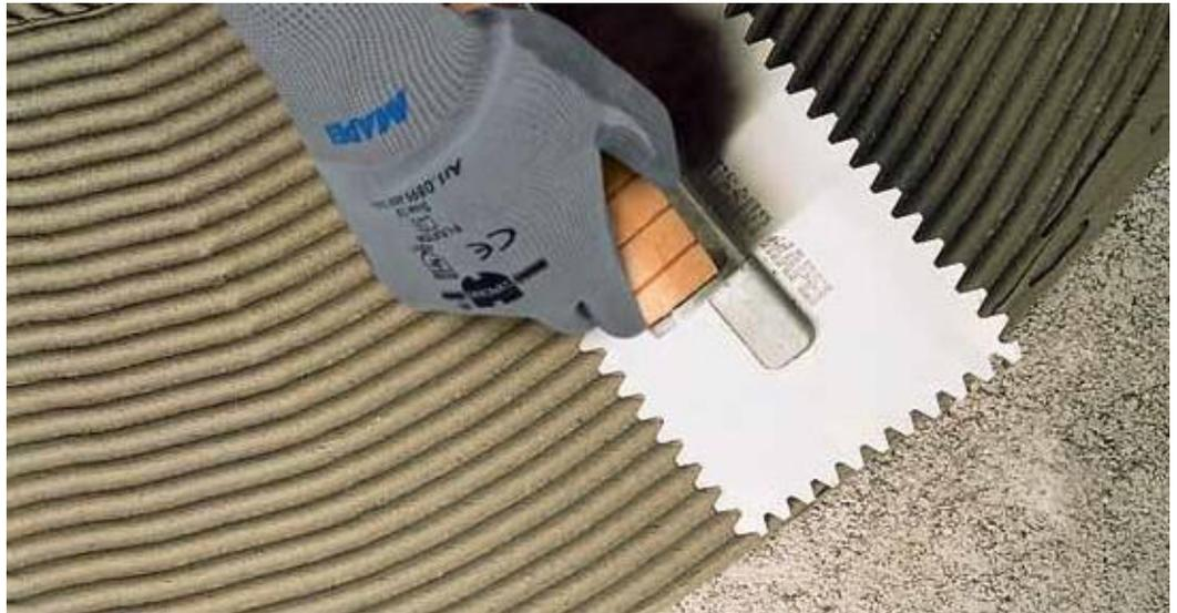
absorbentes o aislantes, aplicar **Adesilex P9 Porcellanato** con llana dentada por puntos.
